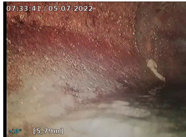
Foto: 2_13B, Media nr.: 060722_1, 00:01:00 5,83m, Fogförskjutning 2. Förskjutningen är mellan halva och hela godstjockleken (avser tvärförskjutning), Kl. 12 , Längsförskjutning.
