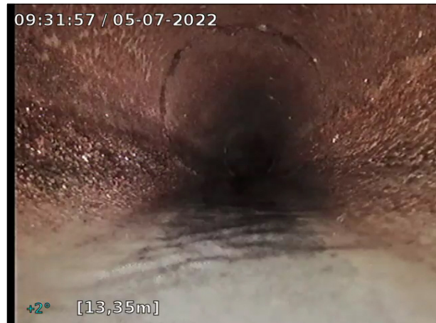
Foto: 5_25A, Media nr.: 060722_1, 00:01:00 13,47m, Utfällning/Påväxt 1. Reduktionen av tvärsnittsarean är 5 % eller mindre, Utfällning.
