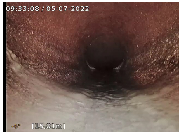
Foto: 5_28A, Media nr.: 060722_1, 00:01:00 15,98m, Sprickor 2. Ej öppen spricka, Kl. 12 , Cirkulär.
