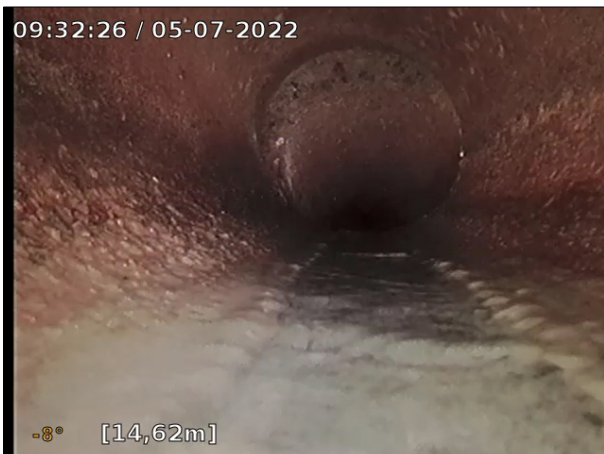
Foto: 5_27A, Media nr.: 060722_1, 00:01:00 14,89m, Fogförskjutning 2. Förskjutningen är mellan halva och hela godstjockleken (avser tvärförskjutning), Kl. 12 , Längsförskjutning.
