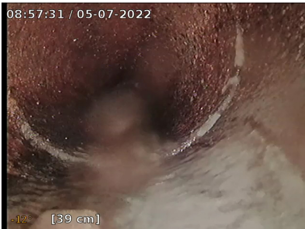
Foto: 3_5A, Media nr:: 060722_1, 00:01:00 0,43m, Fogförskjutning 1. Fogförskjutningen är mindre än halva godstjockleken (avser tvärförskjutning), Kl. 12 , Tvärförskjutning., Börjar
