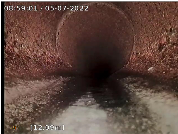
Foto: 3_11A, Media nr:: 060722_1, 00:01:00 12,45m, Fogförskjutning 1. Fogförskjutningen är mindre än halva godstjockleken (avser tvärförskjutning), Kl. 12 , Längsförskjutning., Börjar
