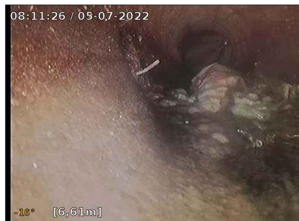
Foto: 2_14B, Media nr.: 060722_1, 00:01:00 6,27m, Fogförskjutning 2. Förskjutningen är mellan halva och hela godstjockleken (avser tvärförskjutning), Kl. 12 , Längsförskjutning.
