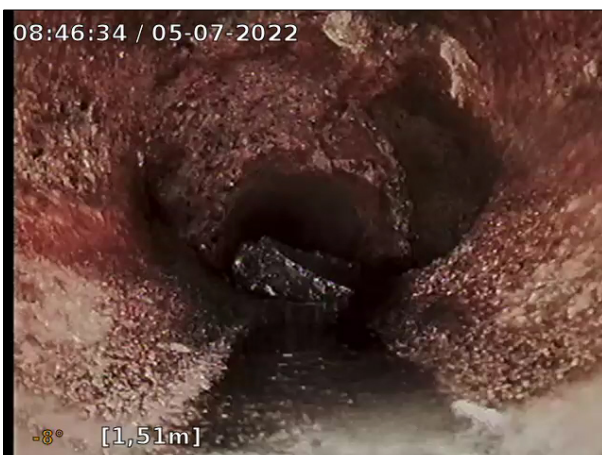
Foto: 3_6B, Media nr:: 060722_1, 00:01:00 1,26m, Rörbrott 4. Kollaps - Rörets tvärsnitt har förändrats/rasat samman., Klockan 12 till 12 , Börjar
