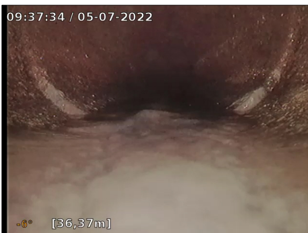
Foto: 5_43A, Media nr:: 060722_1, 00:01:00 36,73m, Fogförskjutning 1. Fogförskjutningen är mindre än halva godstjockleken (avser tvärförskjutning), Kl. 12 , Tvärförskjutning., Börjar
