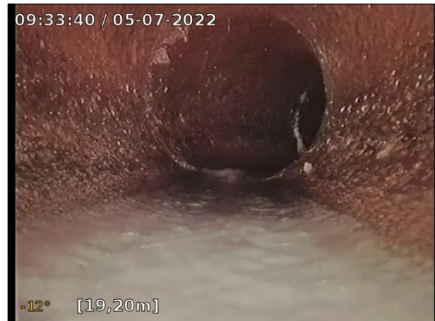
Foto: 5_31A, Media nr:: 060722_1, 00:01:00 19,54m, Utfällning/Påväxt 1. Reduktionen av tvärsnittsarean är 5 % eller mindre, Utfällning., Börjar
