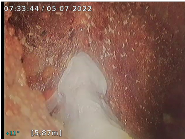
Foto: 2_13A, Media nr.: 060722_1, 00:01:00 5,83m, Fogförskjutning 2. Förskjutningen är mellan halva och hela godstjockleken (avser tvärförskjutning), Kl. 12 , Längsförskjutning.
