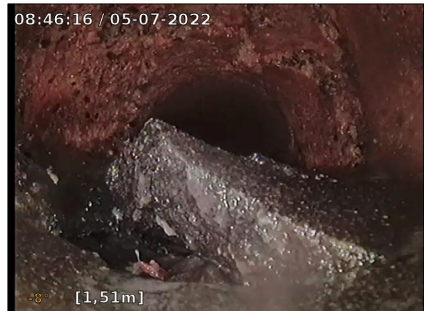
Foto: 3_6A, Media nr:: 060722_1, 00:01:00 1,26m, Rörbrott 4. Kollaps - Rörets tvärsnitt har förändrats/rasat samman., Klockan 12 till 12 , Börjar
